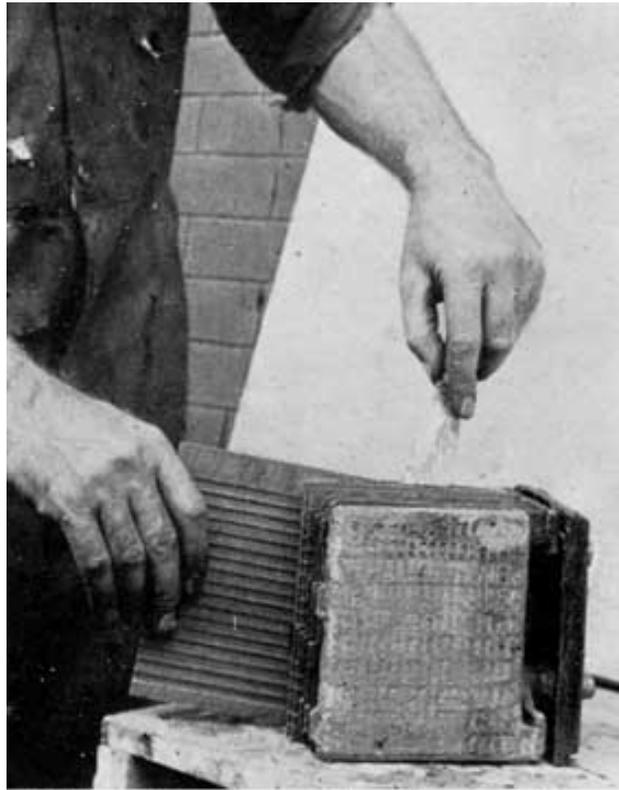
Fig. 225. Inserting Separators
